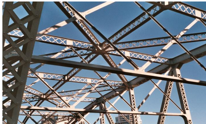
Şekil 2: T-profillerin çelik bir köprüde çapraz elemanları olarak kullanımı (URL-2, 2024)
